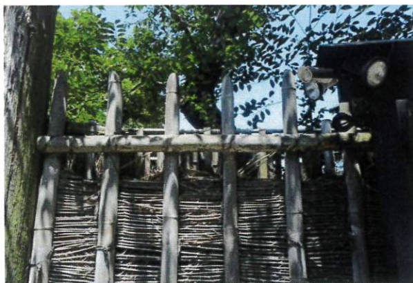
正門桂垣（穂垣）改修（修理前）
