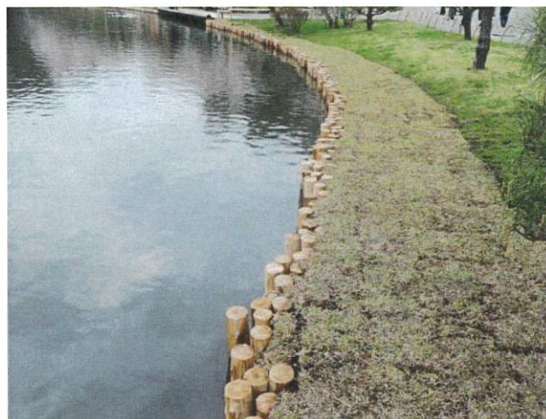
大池護岸修理（西護岸）（工事後）
