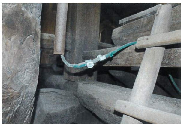
(旧燈明寺三重塔避雷針改善工事 施工前)
