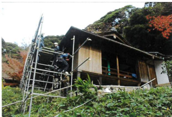
素屋根組立実施状況
