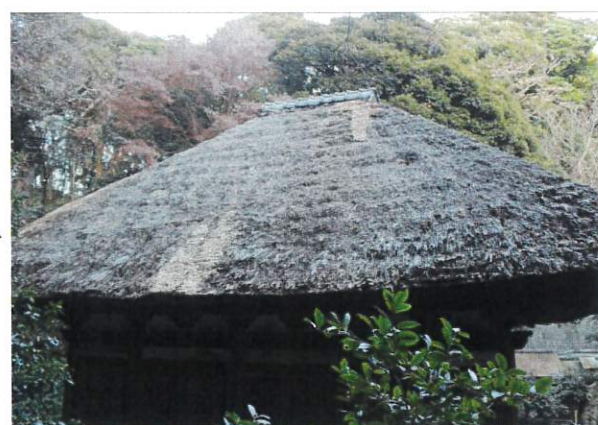
(天授院茅葺屋根差茅工事 施工後)
