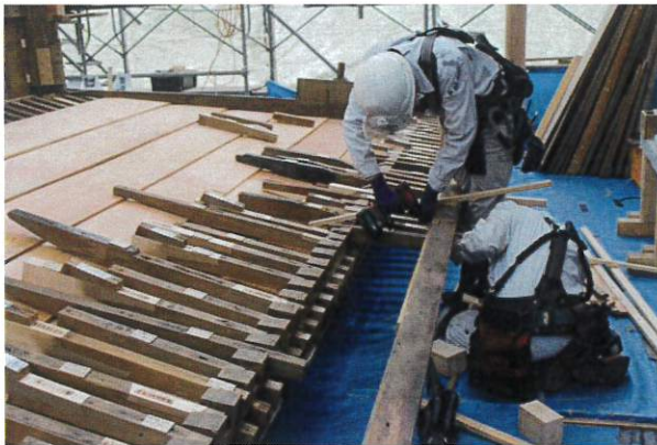
組立工事実施状況
