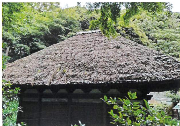
(天授茅葺屋根差茅工事 施工前)
