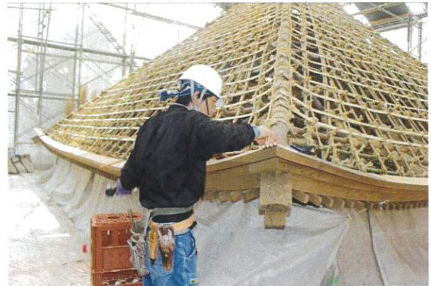
茅葺屋根施工状況
