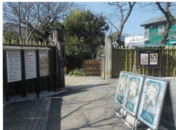
正門桂垣（穂垣）改修（修理後）
