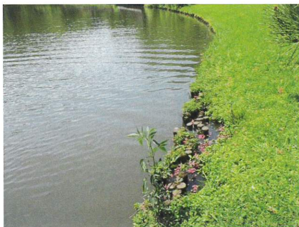
大池護岸修理（西護岸）（工事前）
