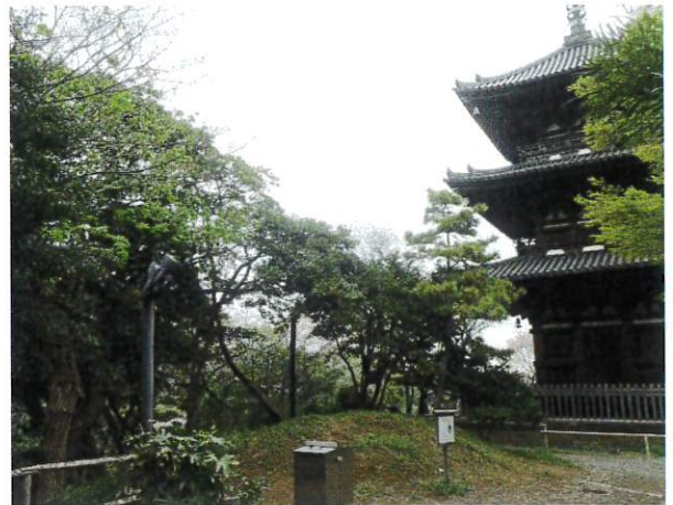
：旧燈明寺三重塔南側マツ枯れ工事後
