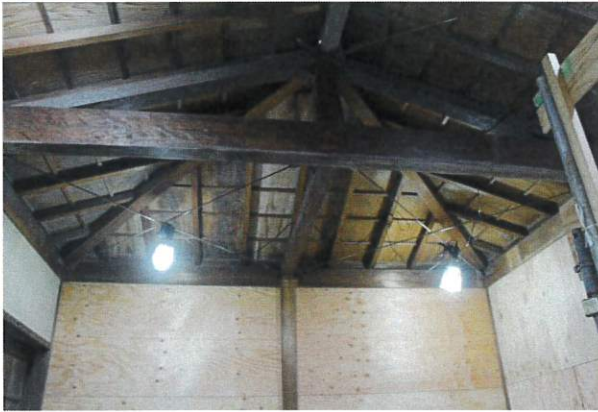
玄関棟耐震補強工事施工状況
