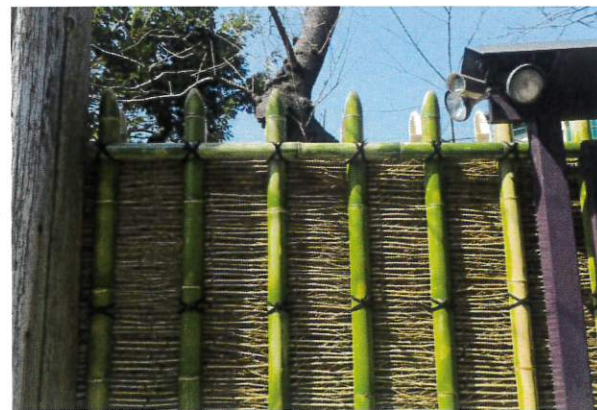
正門桂垣（穂垣）改修（修理後）
