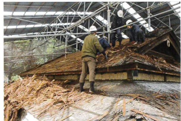
檜皮葺・柿葺き屋根解体状況
