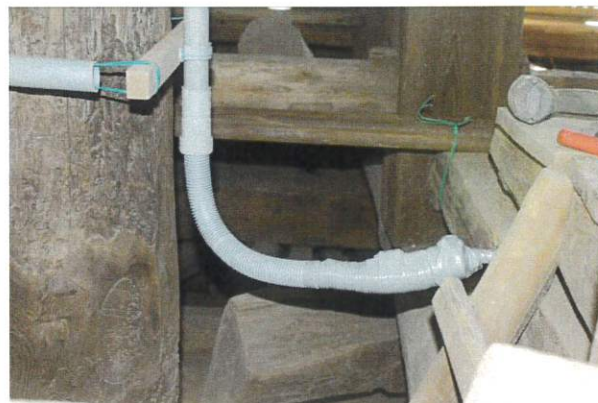
(旧燈明寺三重塔避雷針改善工事 施工後)
