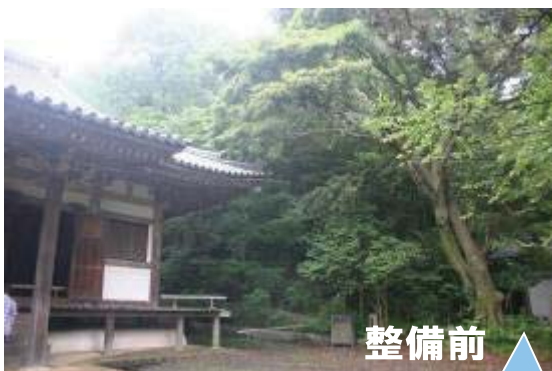
旧燈明寺本堂南側 (待春軒東側)
