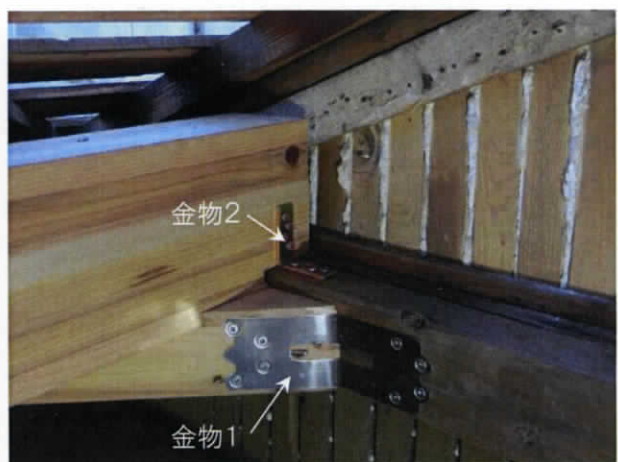
金物1で火打ち梁を桁(茶室妻側)に固定 金物2でつなぎ梁を桁に固定(茶室妻側)
