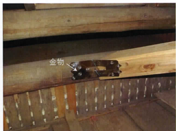
金物で火打ち梁を丸桁に固定
