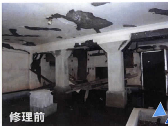
地下躯体補強工事
