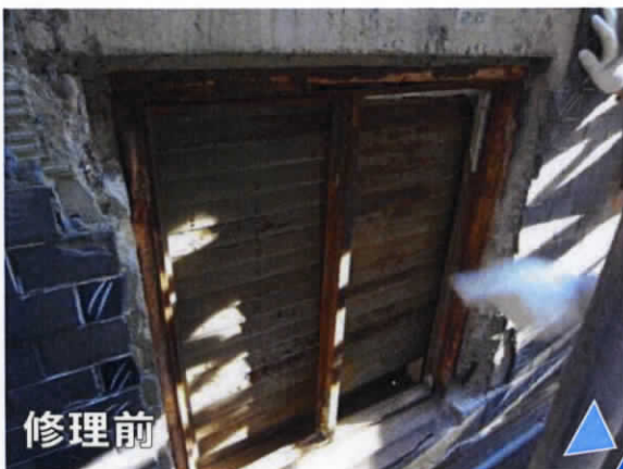
建具工事(スチールサッシ)
