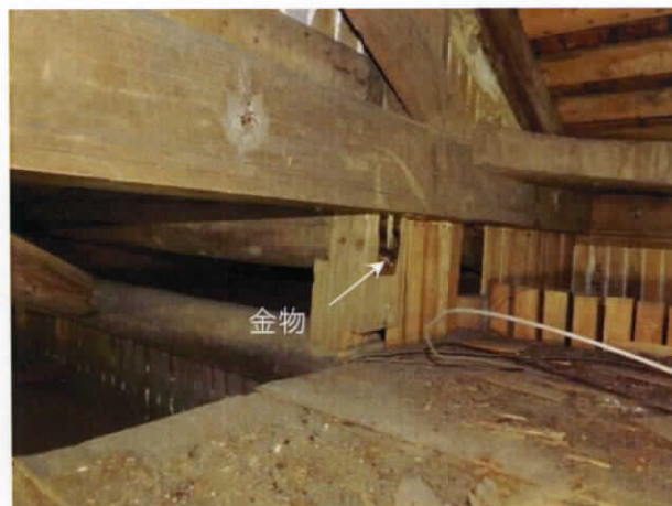
金物で既存の柱と梁を固定
