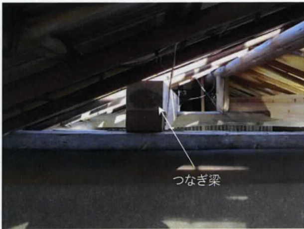
つなぎ梁(補強材)取付状況
