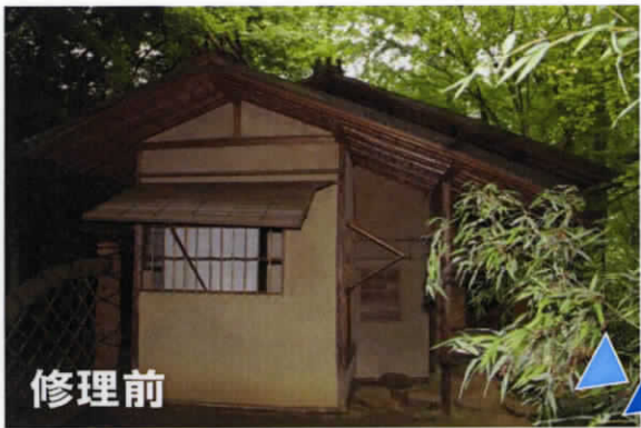
春草廬 西面全景
