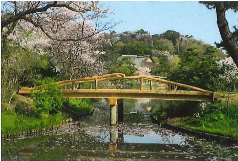
大池中之島木橋 B（仮称） の整備
