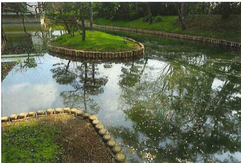
三溪記念館池護岸等の修理
