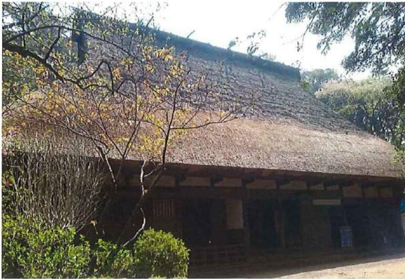
旧矢筈原家住宅茅葺屋根の 修理
