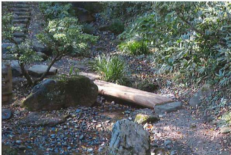
内苑・聴秋閣遊歩道木橋 (下流部) の整備
