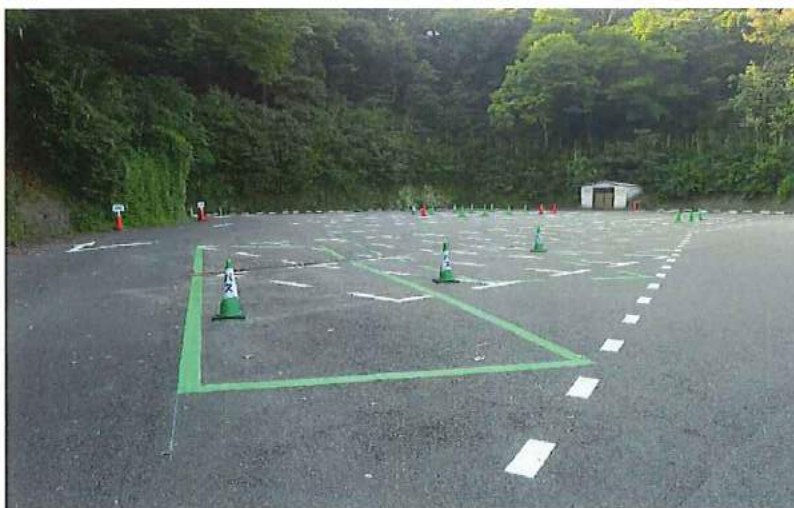
駐車場区画線の整備
