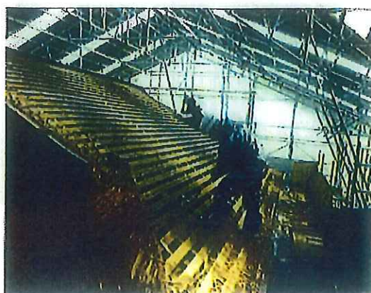
(桧皮葺屋根解体状況)
