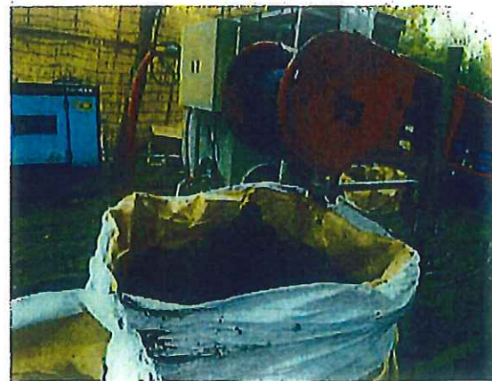
脱水土詰め込み状況 (工事中)
