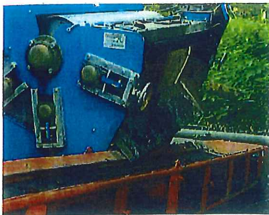
脱水土詰め込み状況 (工事中)
