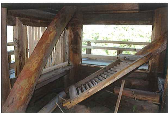
(旧燈明寺三重塔 工事前)
