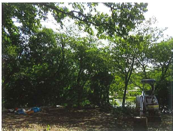
(観心橋附近 施工前)
