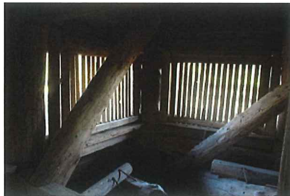
(旧燈明寺三重塔 工事後)
