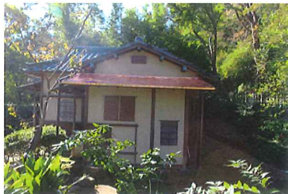
(林洞庵 工事後)
