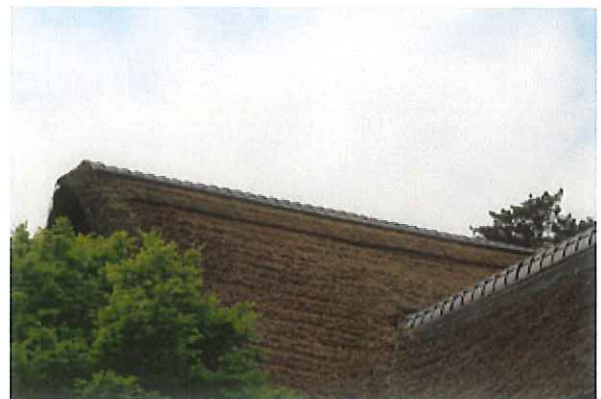
(鶴翔閣棟積みなおし・差茅工事 施工後)
