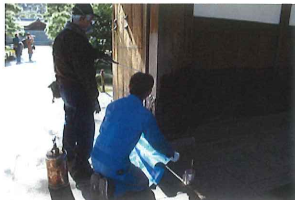
(御門防蟻処理施工状況)
