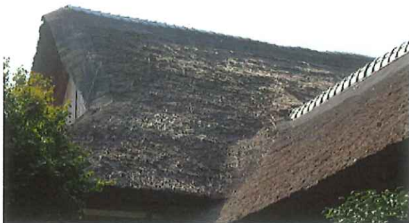
(鶴翔閣棟積みなおし・差茅工事 施工前)
