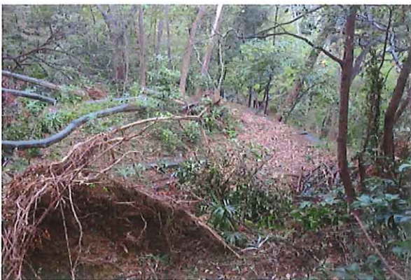
(春草廬周辺山林部 施工前)
