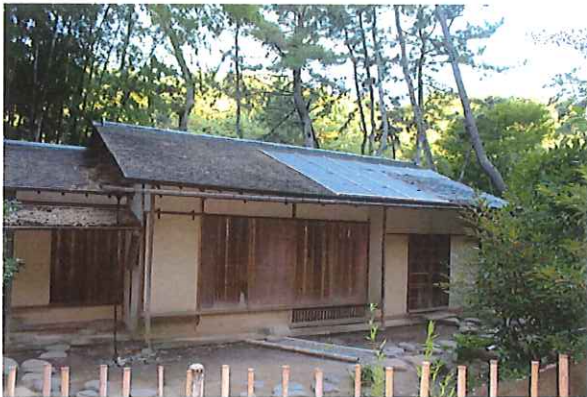
(蓮華院屋根葺替工事 施工前)
