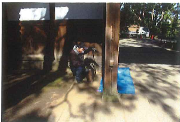
(御門防蟻処理施工状況)
