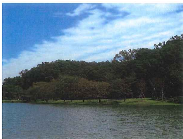
(西側からの景色 施工後)
