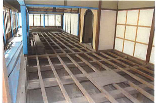
(耐震壁施工のための解体状況)
