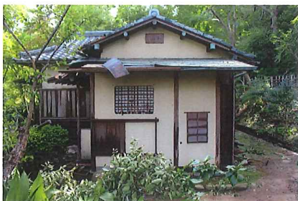
(林洞庵 工事前)
