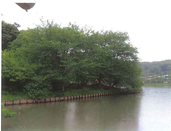
(正門側からの景色 施工前)
