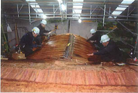
(檜皮葺屋根葺替施工状況)
