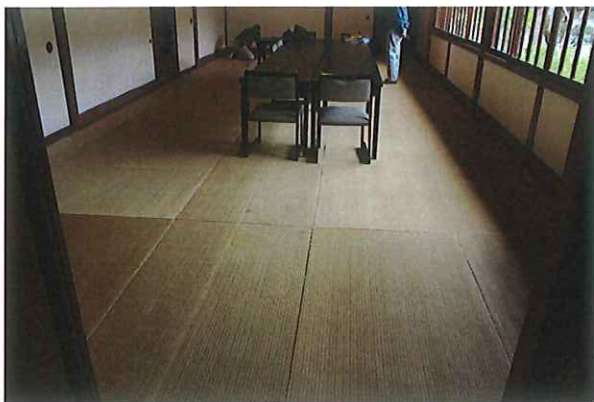
(白雲邸談話室畳表替工事 工事前)
