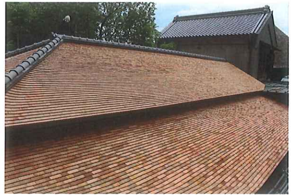
(鶴翔閣客間棟柿葺屋根葺替工事 施工後)
