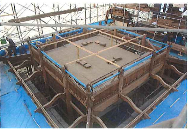
(身舎および庇小屋組解体状況)
