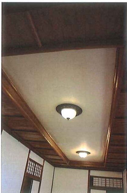
(白雲邸談話室天井貼り付け壁および 照明器具修理工事 工事前)
