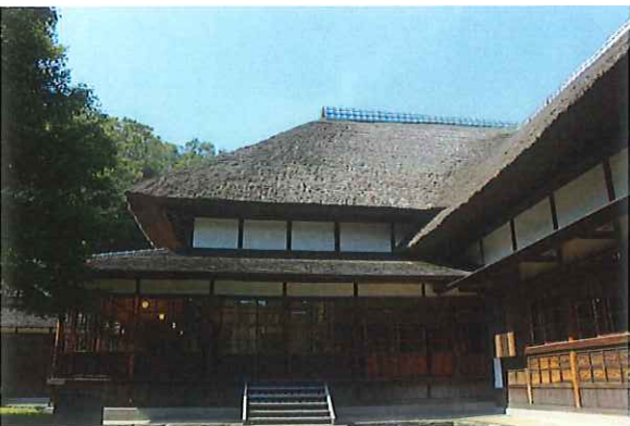
(鶴翔閣楽室棟棟積みなおし工事 施工前)
