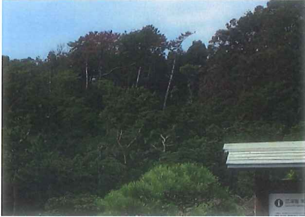
蓮池西側のマツ及びナラ枯れ（工事前）
