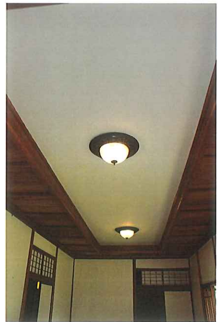
(白雲邸談話室天井貼り付け壁および 照明器具修理工事 施工後)
