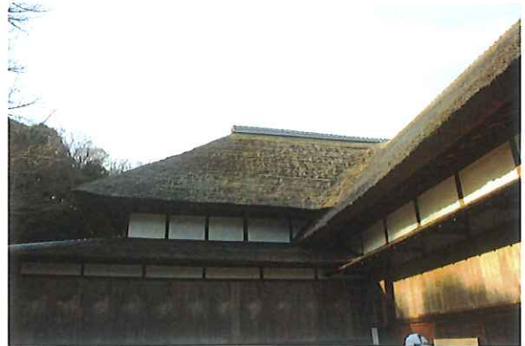
(鶴翔閣楽室棟棟積みなおし工事 施工後)
