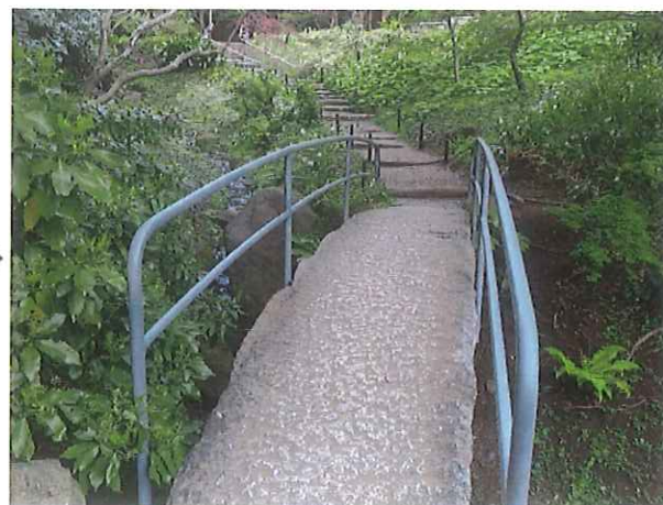
内苑石橋手摺り（修理後）
