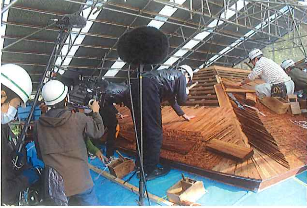
(檜皮葺屋根葺替施工状況)
