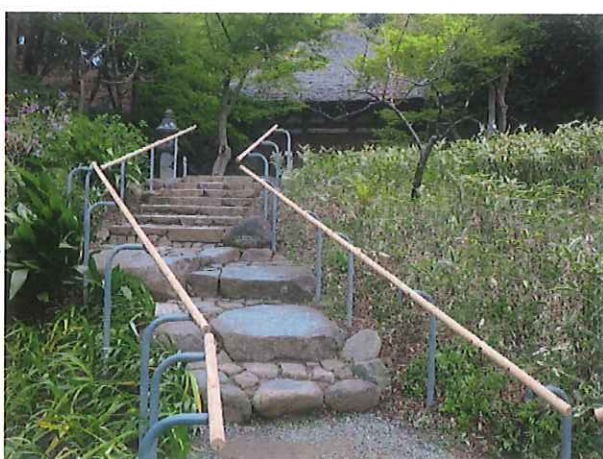
内苑石段手摺り（修理後）
