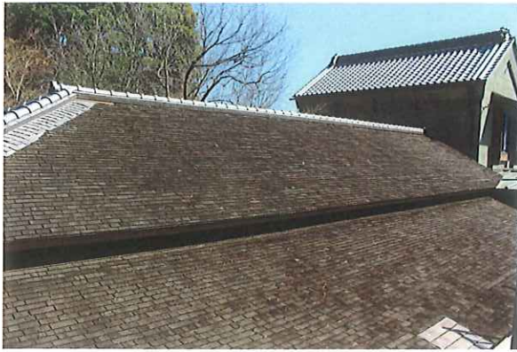
(鶴翔閣客間棟柿葺屋根葺替工事 施工前)
