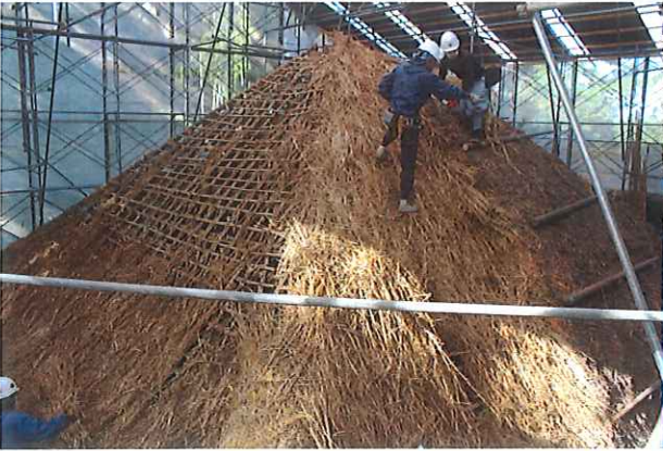
(茅葺屋根解体状況)
