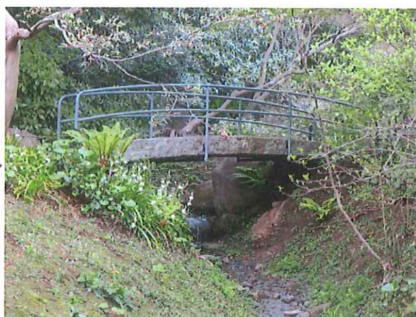
内苑石橋手摺り（修理後）
