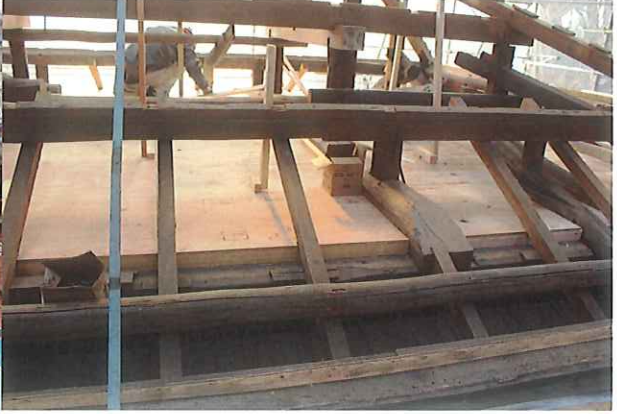
(第三層耐震補強施工状況)
