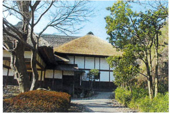
(鶴翔閣楽室棟茅葺屋根差茅工事 施工後)
