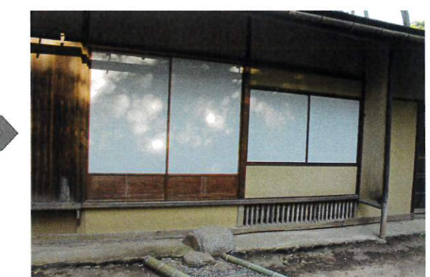
(蓮華院障子張替工事 施工後)
