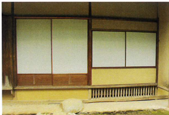
(蓮華院障子張替工事 施工前)
