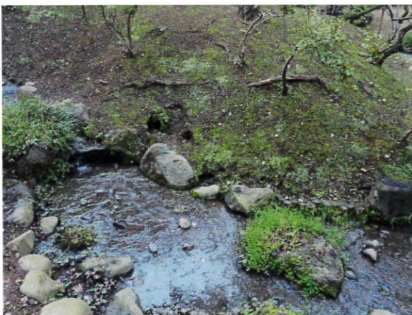
外苑流れ護岸修理（修理前）
