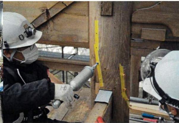
(劣化した柱の補強)
