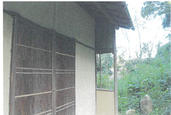
(蓮華院袖壁破損修理工事 施工後)
