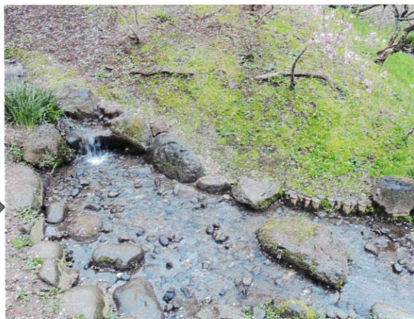
外苑流れ護岸修理（修理後）
