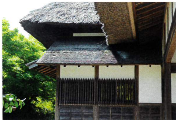
(鶴翔閣玄関庇柿葺屋根葺替 施工前)
