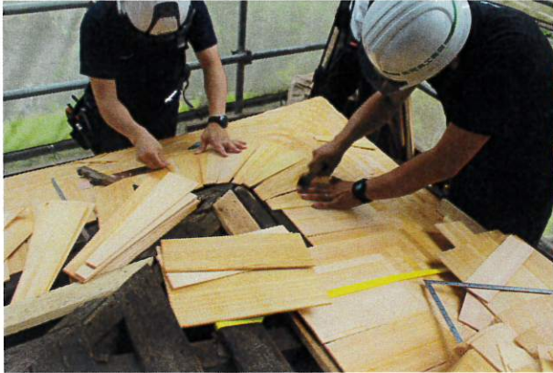
(第三屋こけら葺き屋根葺替施工状況)
