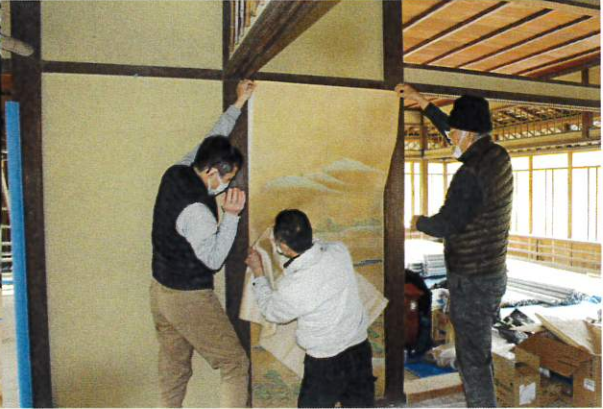
(障壁面貼戻し施工状況)
