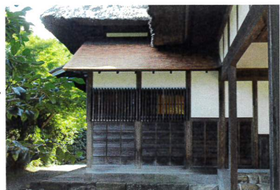
(鶴翔閣玄関庇柿葺屋根葺替 施工後)
