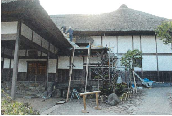
(鶴翔閣楽室棟茅葺屋根差茅工事 施工前)
