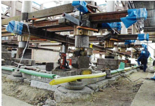
(礎石据え直しのための揚屋工事)
