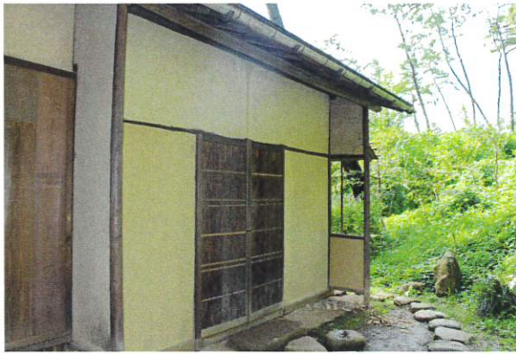
(蓮華院袖壁破損修理工事 施工前)
